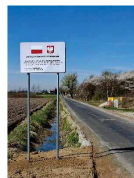
wyremontowana ulica Krzyżowa
