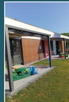
Zakup i montaż zadaszeń w Publicznym Żłobku w Polskiej Nowej Wsi kwota: 80 000,00 zł
