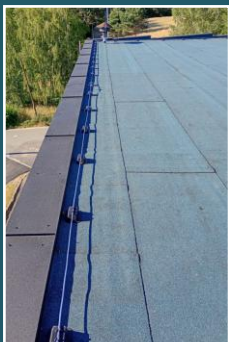
Remont dachu OSP Domecko kwota: 119 484,10zł
